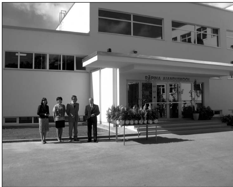
Räpina Aianduskooli renoveeritud õppehoone.
